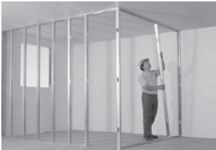
Instalación del montaje
