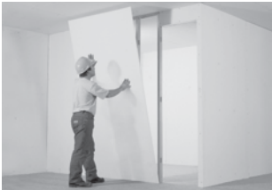
Colocación de revestimientos
