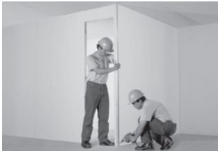
Instalación de ángulo esquinero
