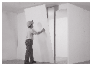
Colocación de revestimientos
