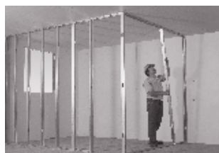
Instalación del montaje
