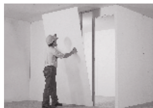
Colocación de revestimientos
