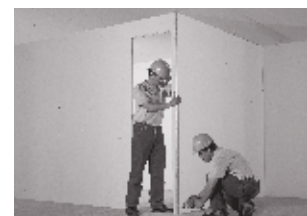
Instalación de ángulo esquinero
